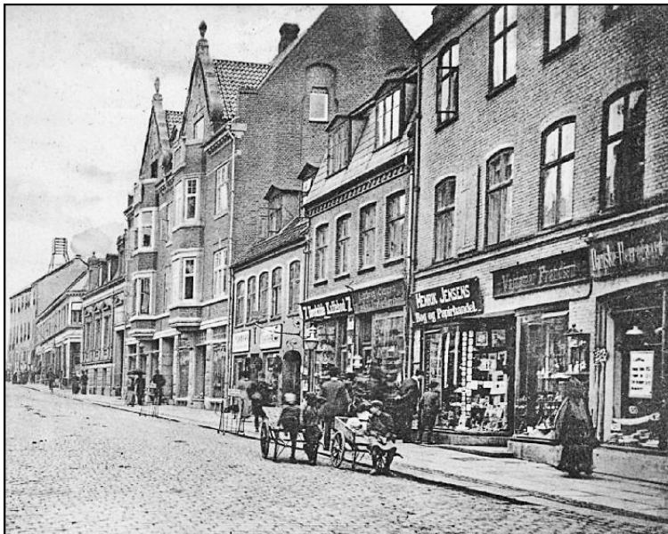
Skomagergade 9 - bygningen helt til højre omkr. 1912/15
