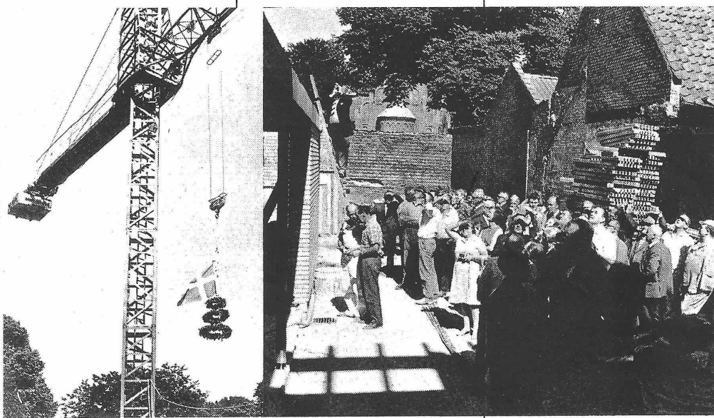
Kransene blev bragt på plads med kranens hjælp. Til højre et udsnit af de mange gæster og håndværkere, der deltog i rejsegildet.
