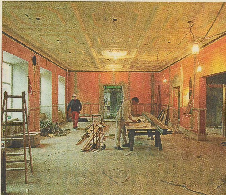
Den lille sal i det gamle kulturhus er udsat for en gennemgribende ombygning. Her skal hotellets nye receptionsfoyer ligge.
