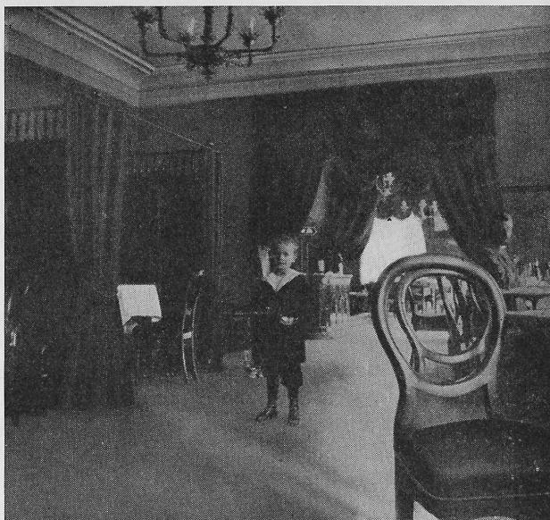
»Prinsen«s restauration sidst i 90'erne. Bemærk »båsene« og gaslysekronen. Artiklens forfatter står med et saltkar og en »plat de ménage« i hånden.
